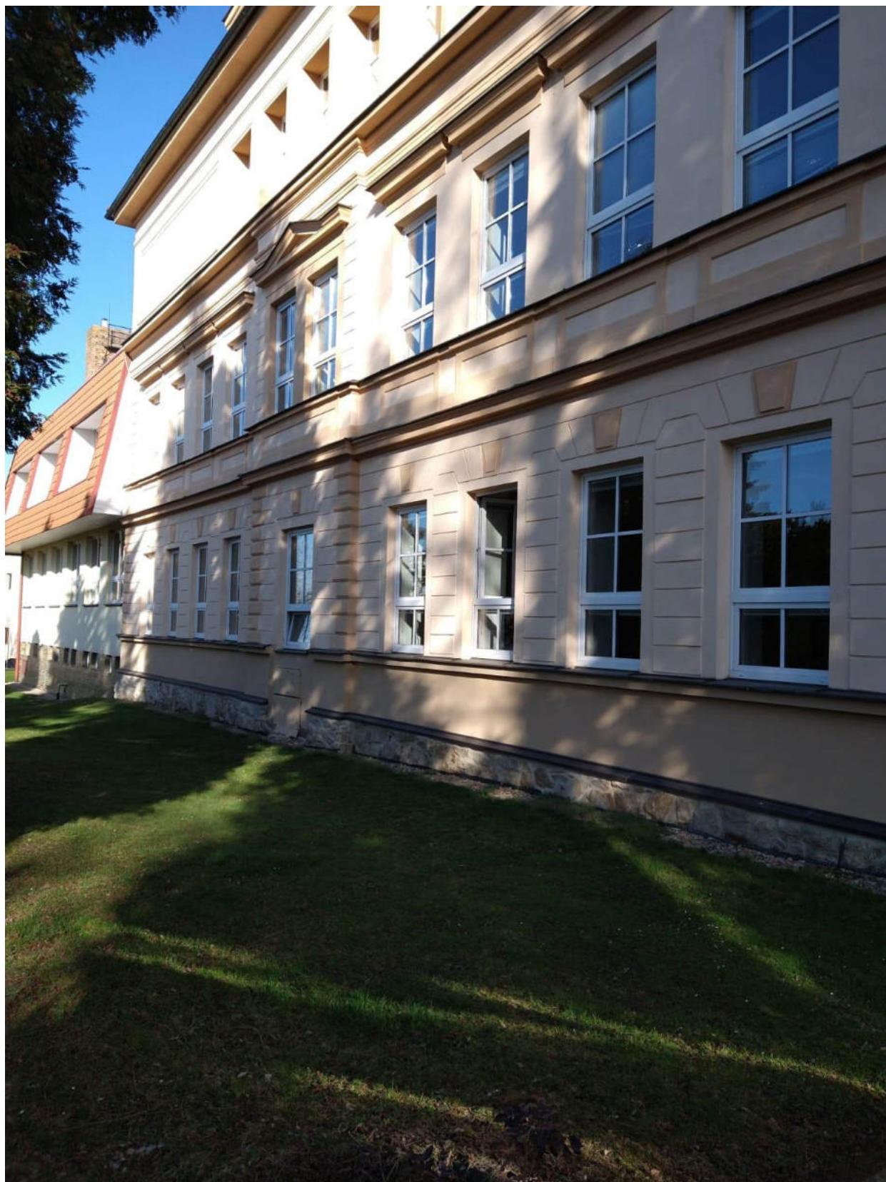
Bližší pohled na jižní stranu budovy ZŠ Bernartice (zdroj: vlastní foto)
