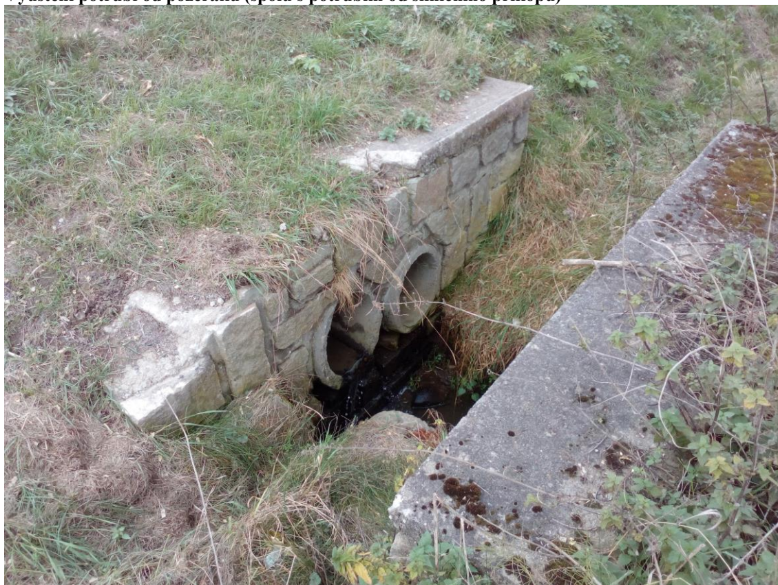
Vyústění potrubí od požeráku (spolu s potrubím od silničního příkopu)
